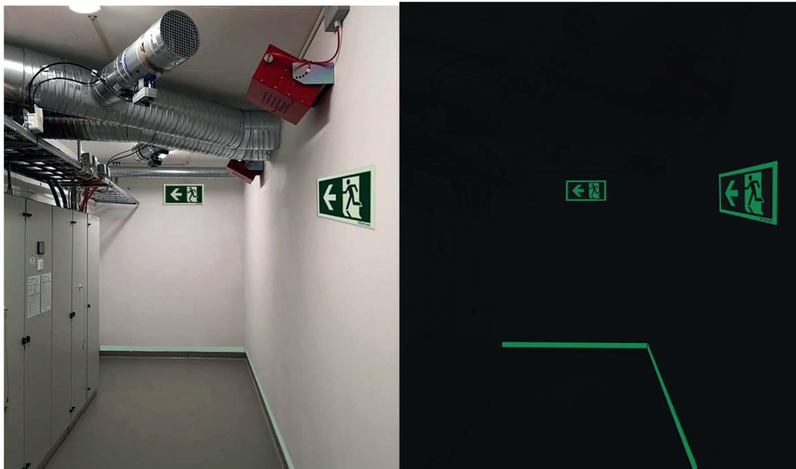
NFPA 2010-standarden for faste aerosol-brannslukkingssystemer beskriver fordelene ved å bruke fotoluminescerende lavt plasserte belysningssystemer i rom som er beskyttet med aerosolsystemer. Den fastslår følgende:
