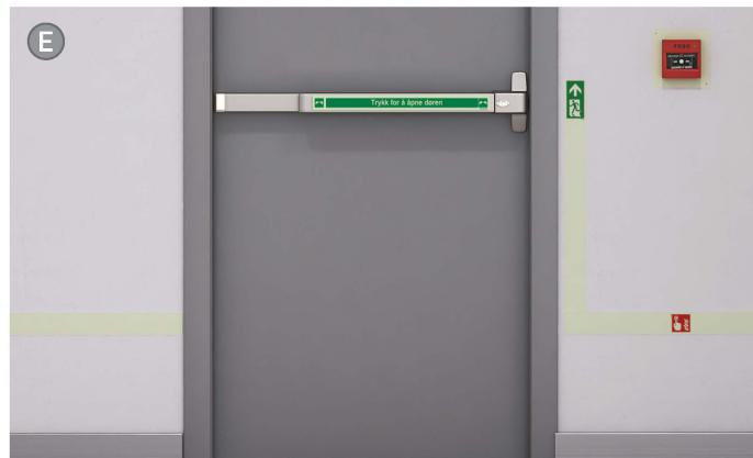
Skilt for rømningsdør (åpnes fra høyre side) med tegning av pannikkbeslag samt lavtsittende skilt og linjer montert i en sikret aluminiumsskinne
